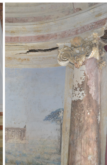
[6] fessurazione delle cornici
